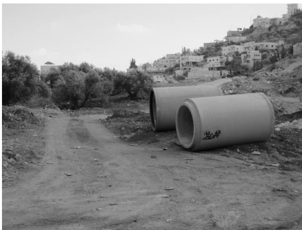
Blick in das Cremisantal bei Bet Jala - für den geplanten Mauerbau werden jahrhundertalte Olivenbäume zerstört
